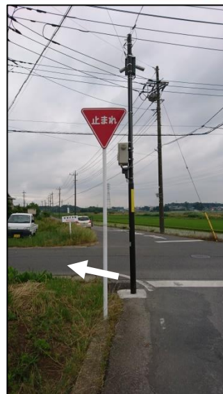
防犯カメラ柱移動前
